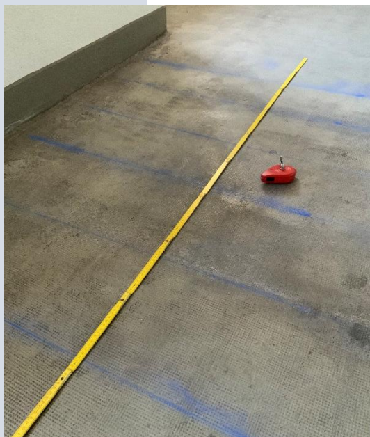
Marquage fin et provisoire sur site de la position des câbles de précontrainte détectés (en bleu) pour des percements. Le radar GPR est particulièrement efficace afin de positionner les câbles de précontrainte dans les éléments en béton armé (6 sont encadrés en rouge sur le scan à une profondeur de 15 cm).
